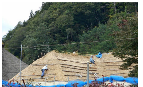
遠野の伝承園で茅葺屋根の葺き替え
